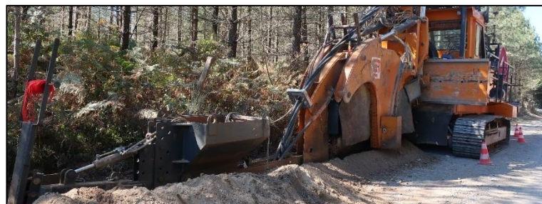
Création d'une tranchée avec une trancheuse
