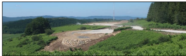
Construction d'une plateforme
