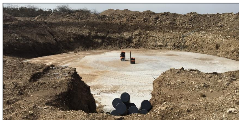
Mise en place du réseau électrique inter-éolien
