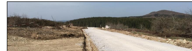
Construction d'une piste en concassés
